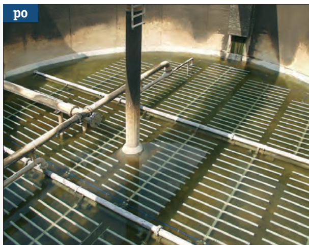
Řešení z polypropylenu nebo HCR nerezové oceli pro použití v provozech s vysokým obsahem chloridu.
