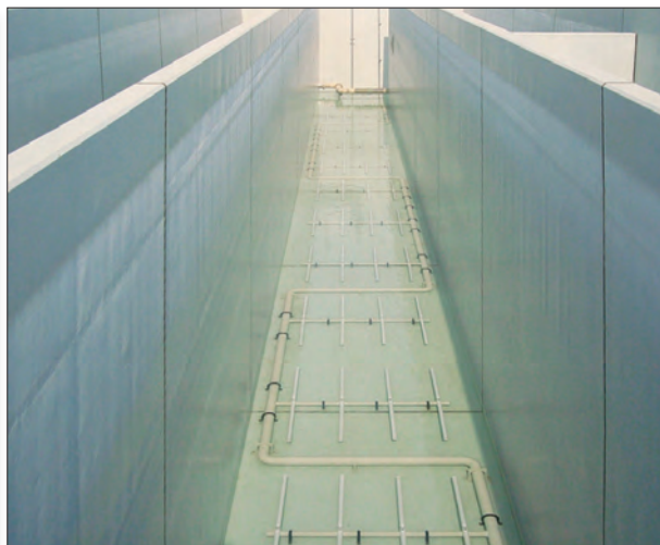
Řešení z polypropylenu nebo HCR nerezové oceli pro použití v provozech s vysokým obsahem chloridu.
