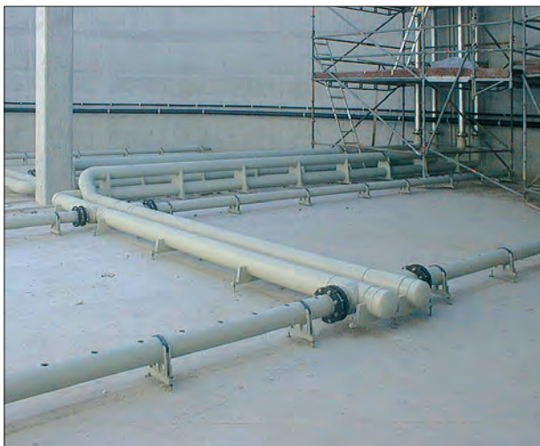
Řešení z polypropylenu nebo HCR nerezové oceli pro použití v provozech s vysokým obsahem chloridu.
